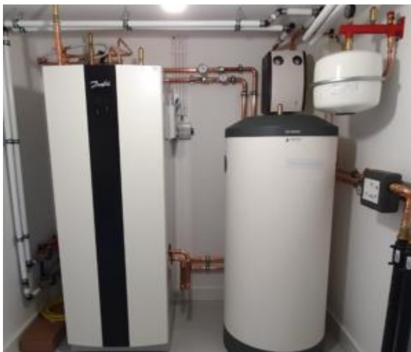
Figuur 19: Warmtepomp bij de lichte en collectieve variant, overgenomen van (Albreco, z.d.)
